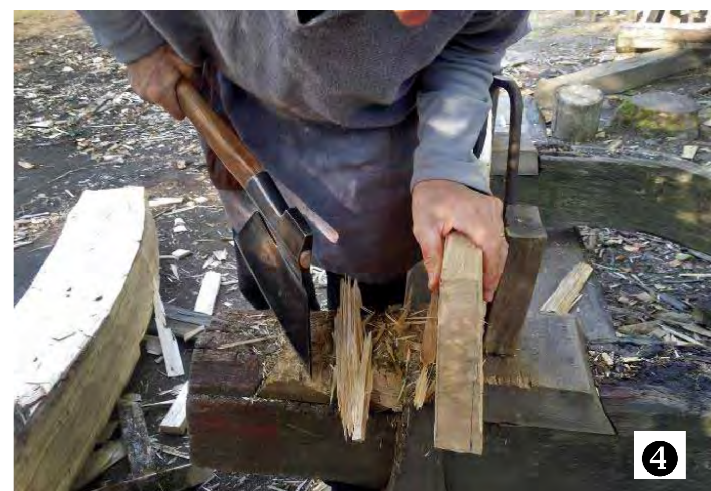
La totalité de la charpente de la halle a été dressée à l'aide de ce seul outil.
